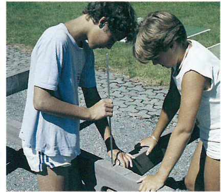
Die vier Betonjoche werden durch Verzahnung mit Steckschrauben zusammengefügt.
